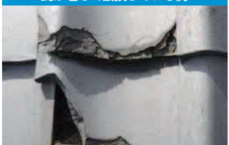
瓦が著しく破損している例
