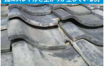
瓦が著しく破損している例
